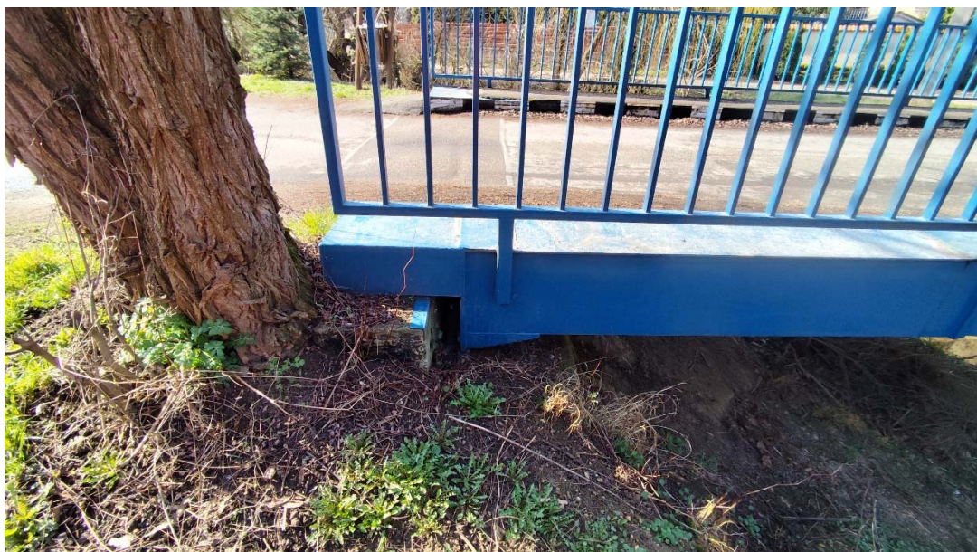
5. kép Felszerkezeti csatlakozás kialakítása
