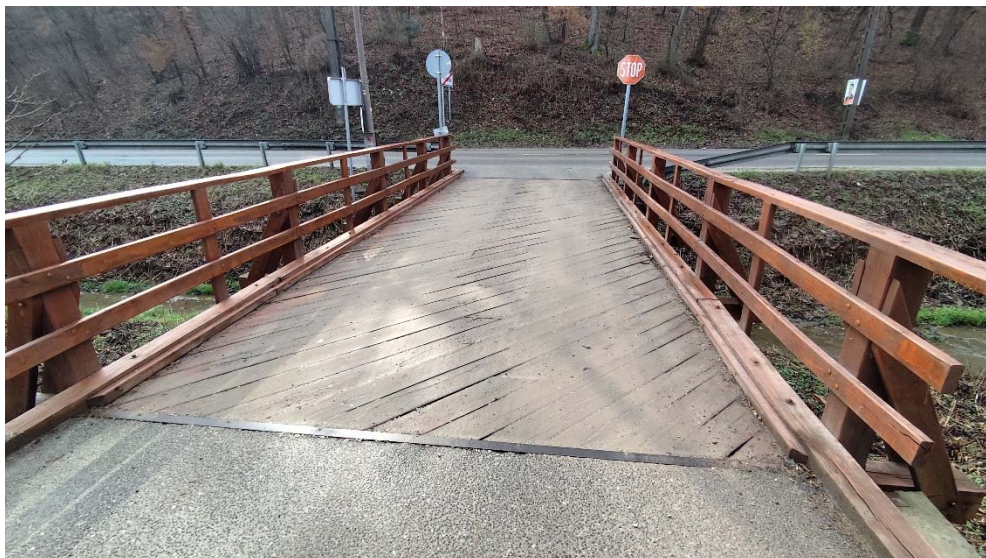
1. kép Híd pályaszerkezete a Nádás utca felől
