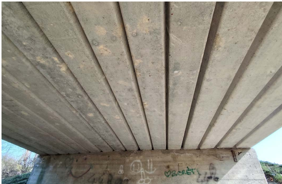
7. kép Vasbeton hídfő és felszerkezet csatlakozása
