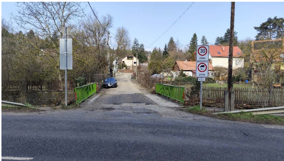
1. kép Híd pályaszerkezete a Fő út felől
