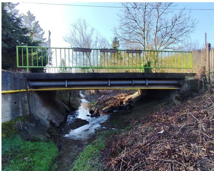
2. kép Híd pályaszerkezete oldalnézetből
