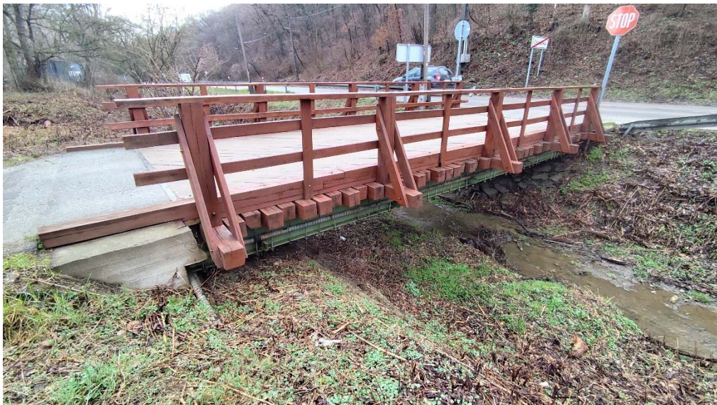
3. kép Híd oldalnézeti képe
