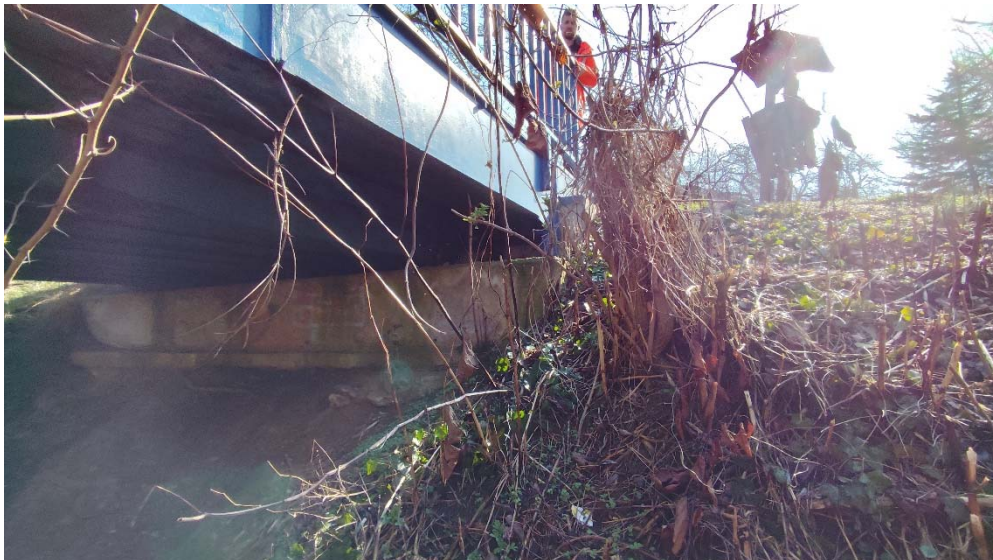
10. kép Felszerkezettel érintkező növényzet
