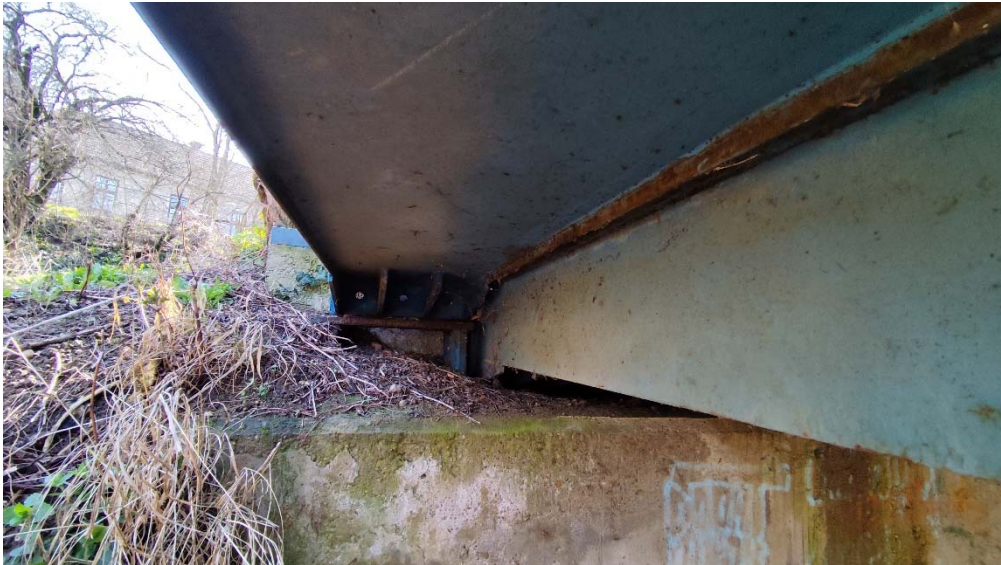
9. kép Acélszerkezetű szegély csatlakozása főtartóhoz
