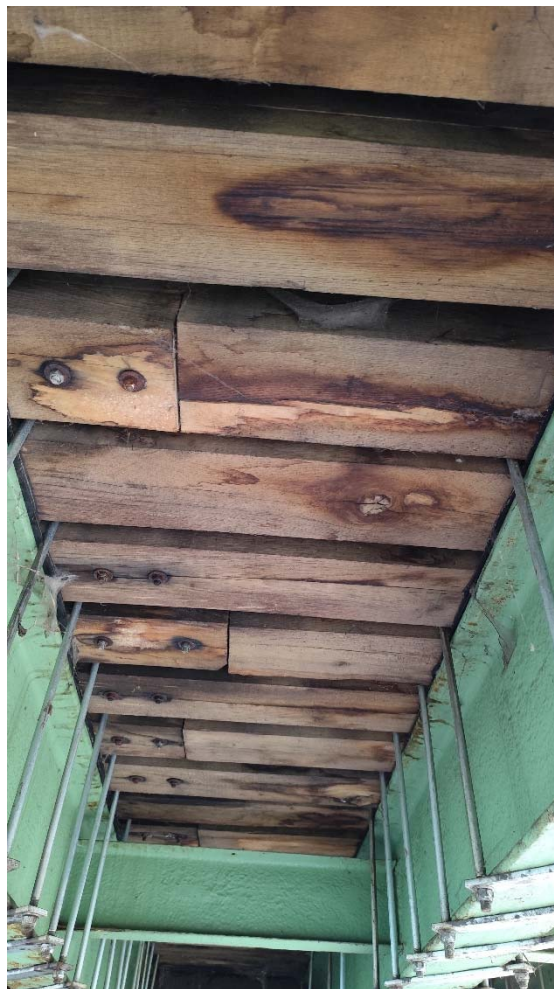
8. kép Pályatartó fa gerendázat rögzítése a főtartókhöz
