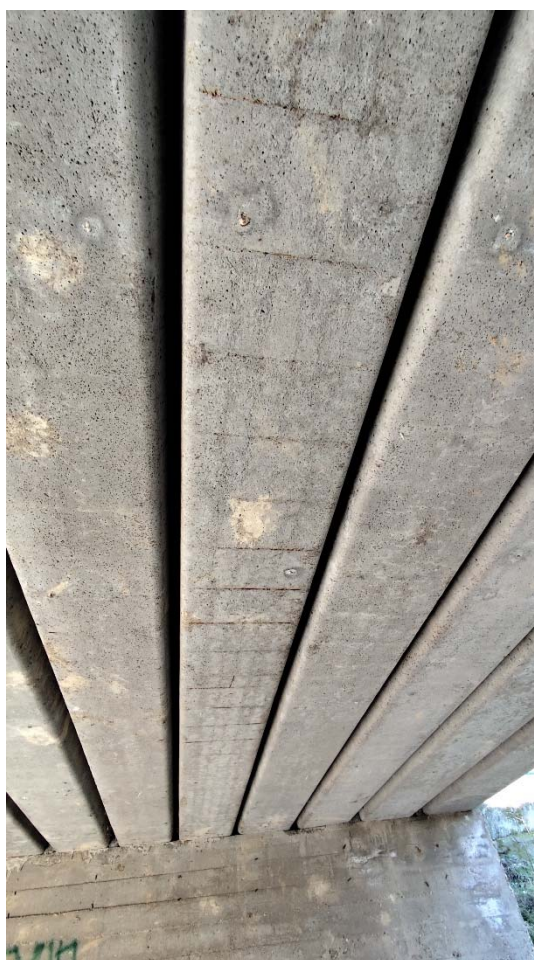
8. kép Nem megfelelő betonfedés miatti betonacél korrózió
