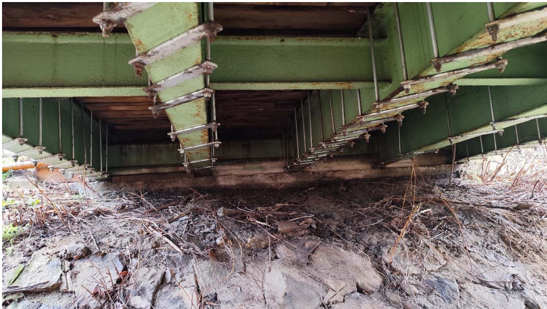
6. kép Keresztmerezvítéssel és csavarozott hevederrel kialakított acél főtartók
