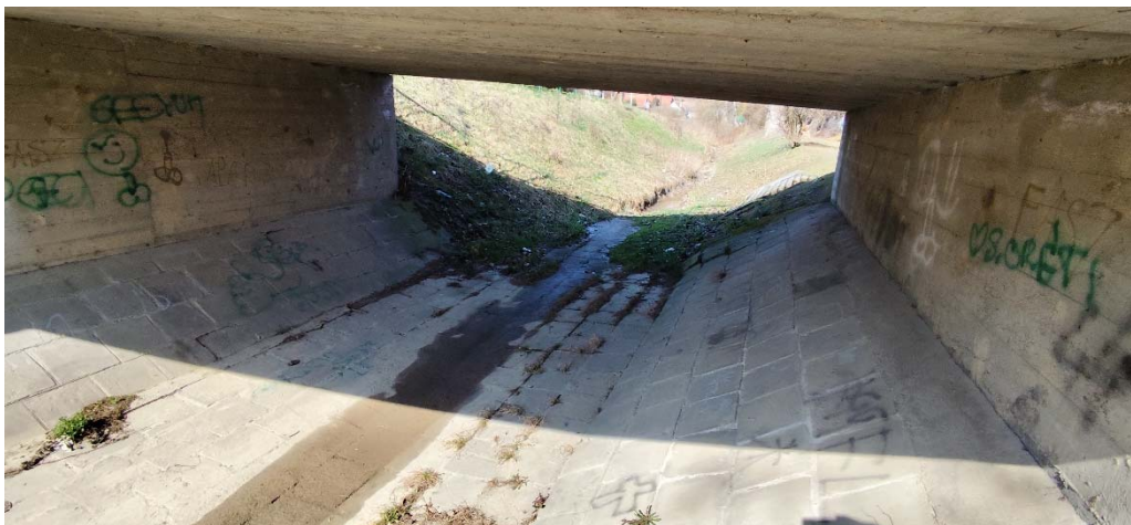
4. kép Rézsűburkolat kialakítása
