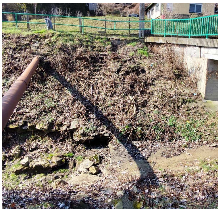
6. kép Növényzettel benőtt vizsgálólépcső
