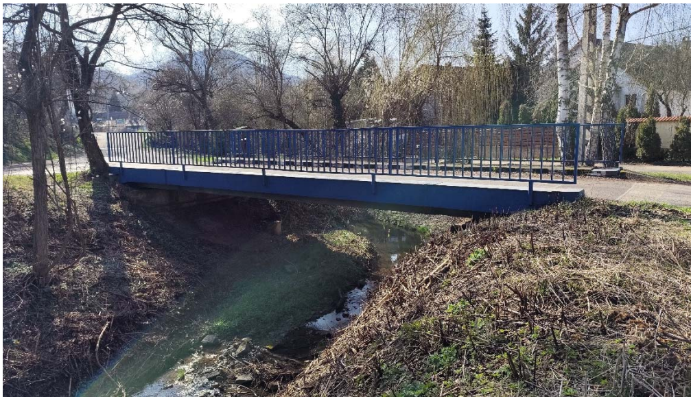
2. kép Híd oldalnézetből
