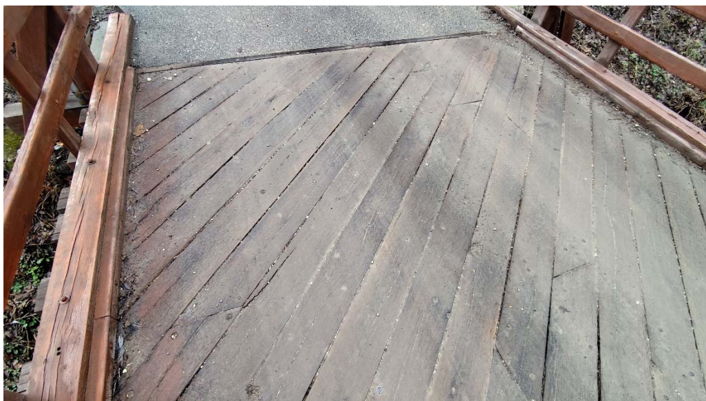
10. kép Felületi kopás a keményfa útburkolaton
