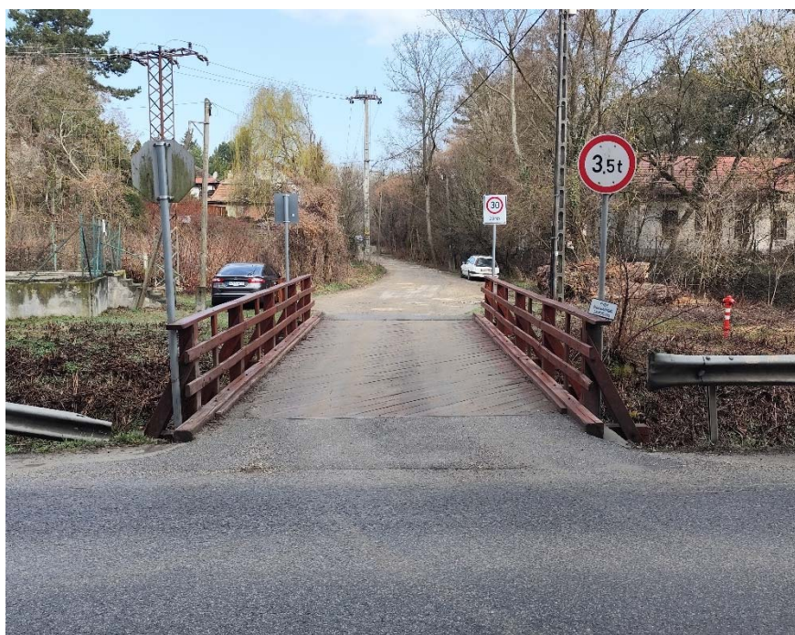
2. kép Híd pályaszerkezete Fő út felől
