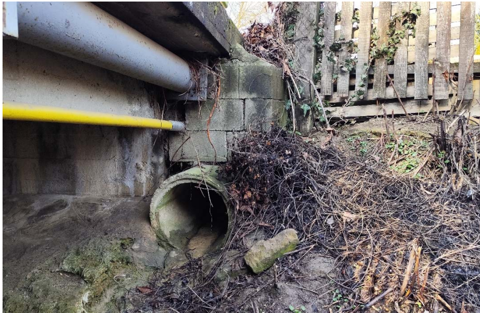
7. kép Közművek, csatornakivezetés a híd szerkezeténél
