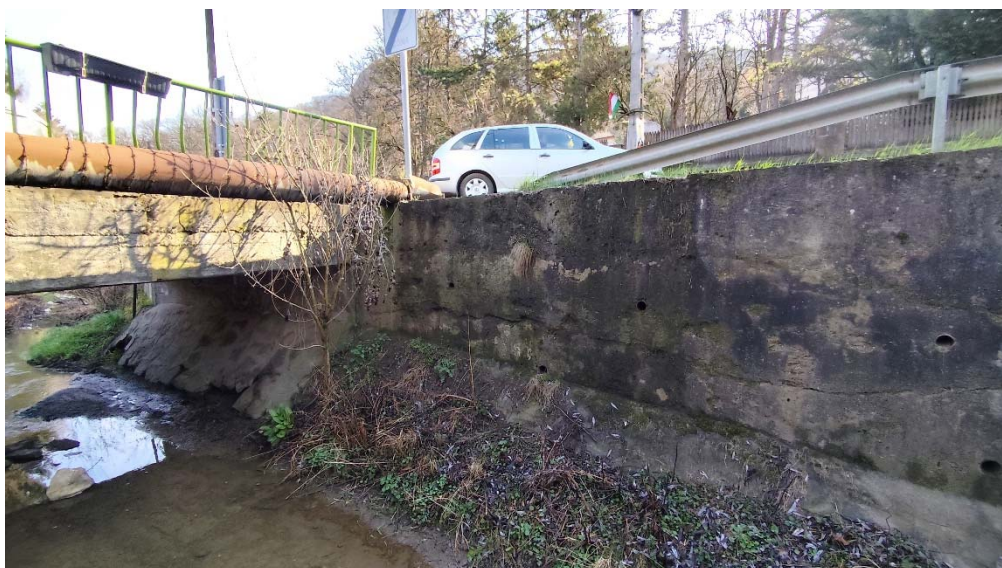
9. kép Hídhöz csatlakozó támfal a Fő út felől
