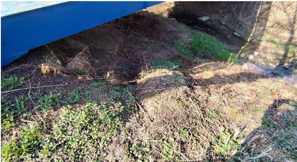
4. kép Híd rézsű kialakítása
