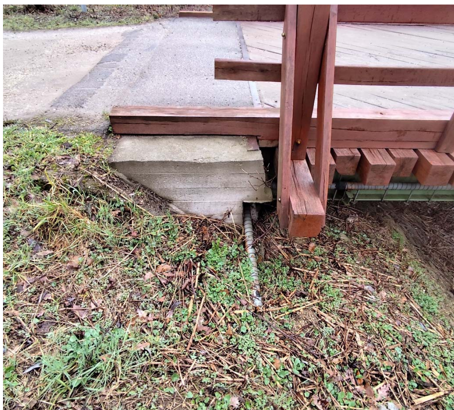
12. kép Csatlakozó út és felszerkezet találkozása Nádas u. felől
