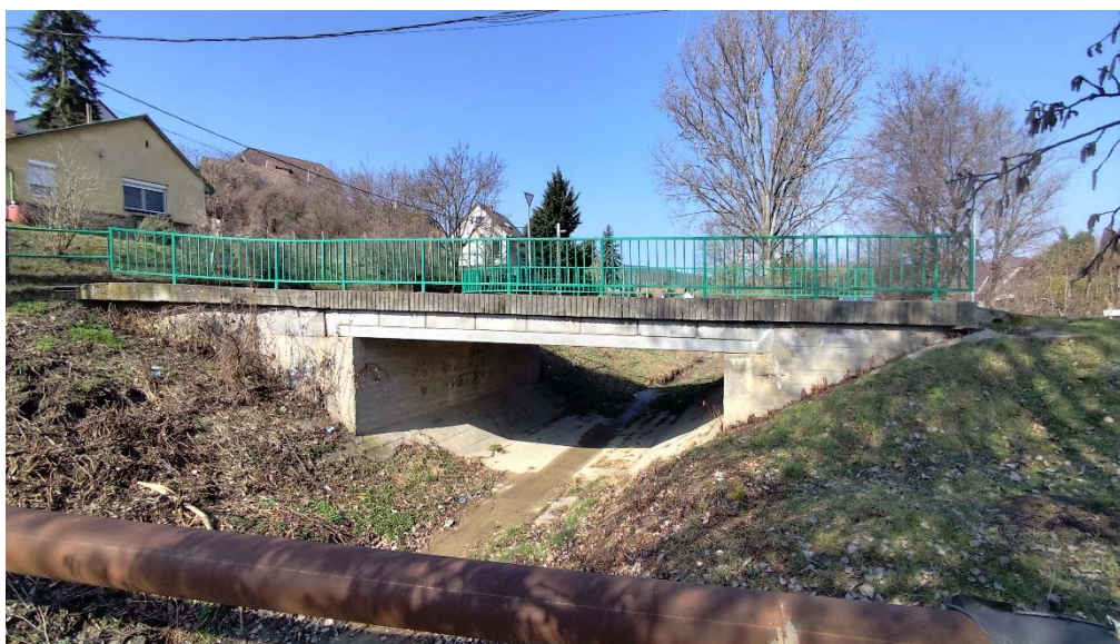
2. kép Híd oldalnézetből
