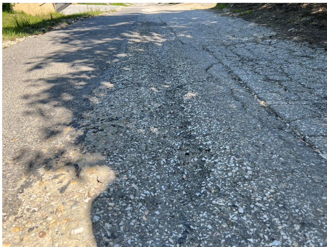
2. kép – széttöredezett útburkolat, letört útszél
