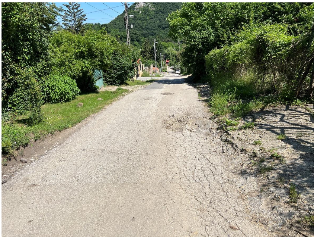
1. kép – mozaikosan összetört útburkolat
