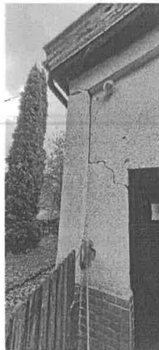
A „vendég” WC ajtaja mellett cm-es nagyságrendű függőleges, majd az ajtónyílás sarkához ferdén kifutó repedés alakult ki.
