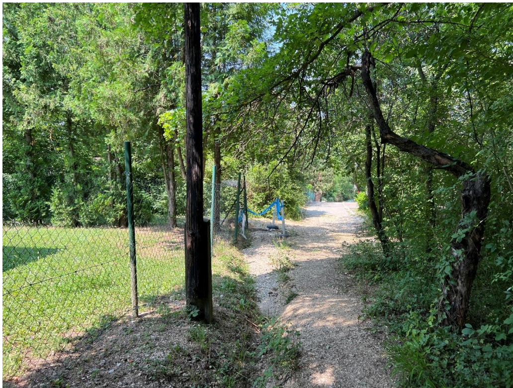
10. kép – Kevély köz 790/5 hrsz. árokkár
